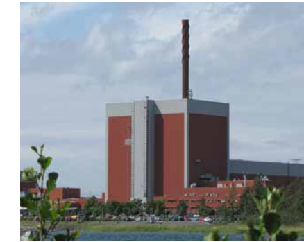
Nuclear Power Plant Olkiluoto 3, Finnland Produkte: KBS® Mortar
